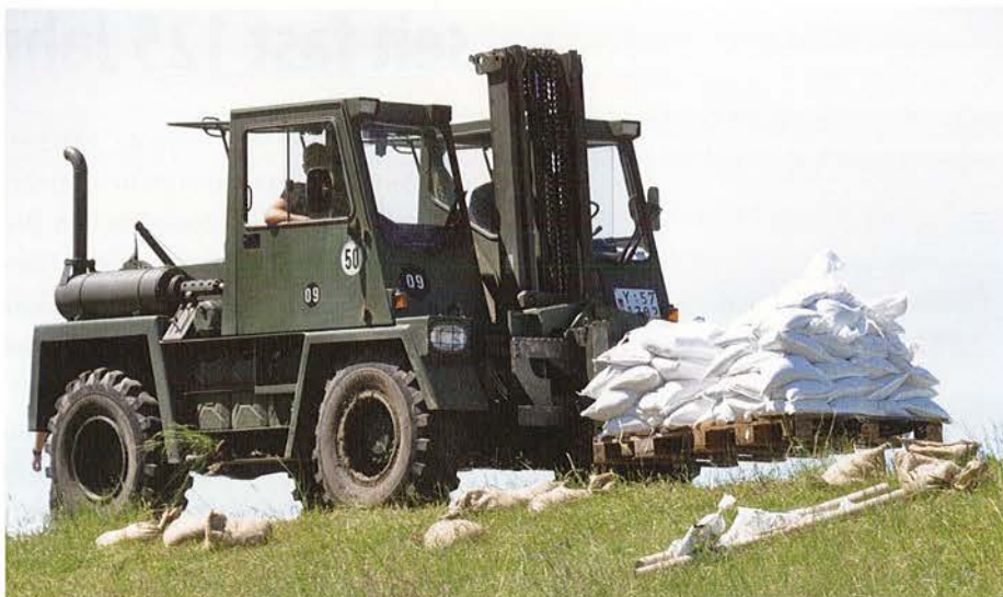
Die Deichkronen müssen instand gesetzt werden, denn beim Aufkaden, der behelfsmäßigen Erhöhung der Deiche mit Sandsäcken, mussten schwere Fahrzeuge eingesetzt werden, die tiefe Spuren hinterlassen haben. Auch die Deichverteidigungswege haben stark gelitten.
