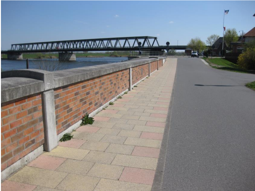
Beispiel: Hochwasserschutzwand Hohnstorf
