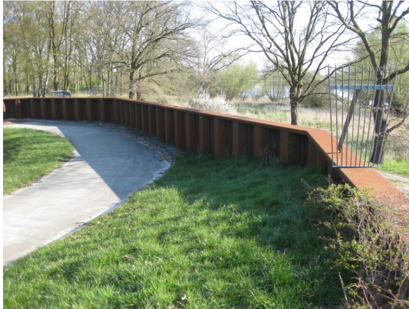
Beispiel: Spundwand Altgarge
