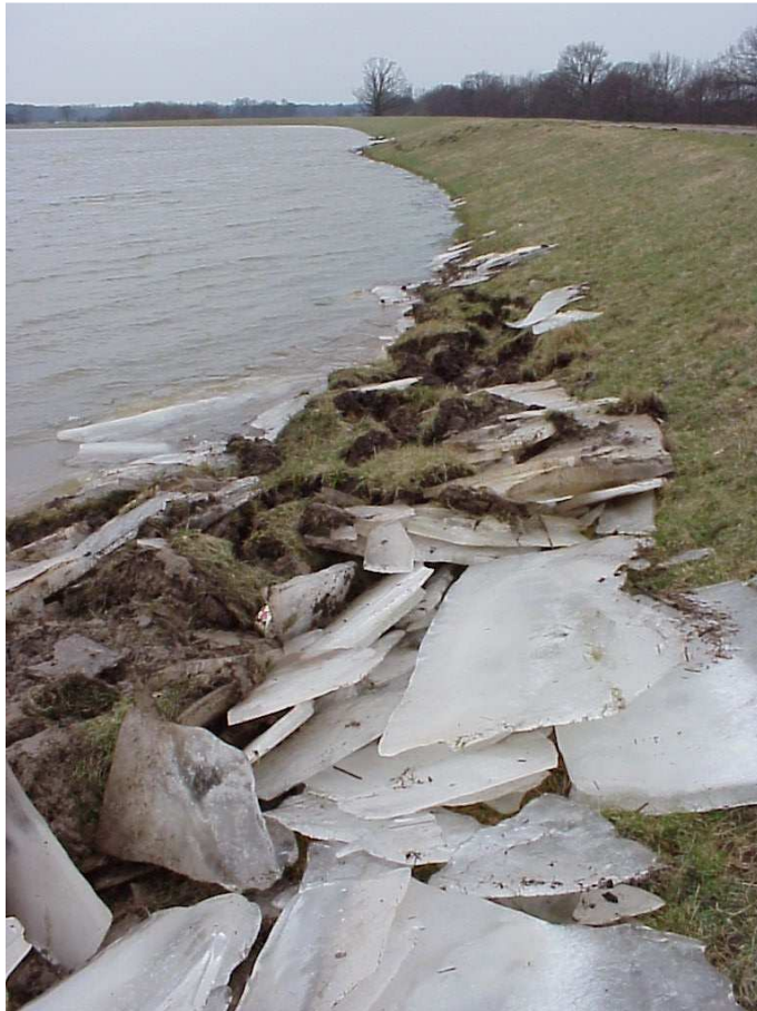
Abbildung 1: Schäden am Deich durch Eisschollen, Hochwasser am 15.01.2003 (Foto Artlenburger Deichverband)
